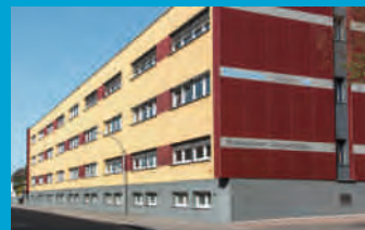
Werkstatt Roßwein II Wehrstraße 27 04741 Roßwein
